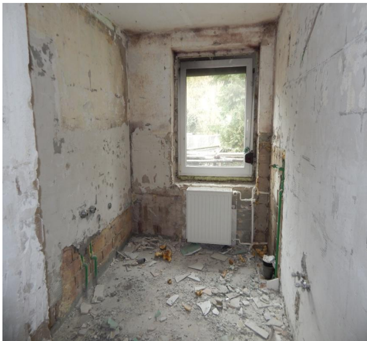
Bad im aktuellem Zustand
