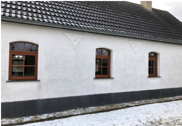
neue Fenster an der Trauerhalle
